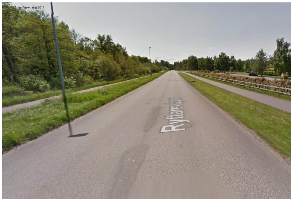
Ryttarevägen södra delen nuläge – vy över gaturummet idag
