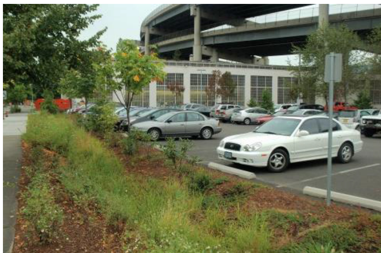
Plantering i svacka där dagvatten infiltrerar i marken.
